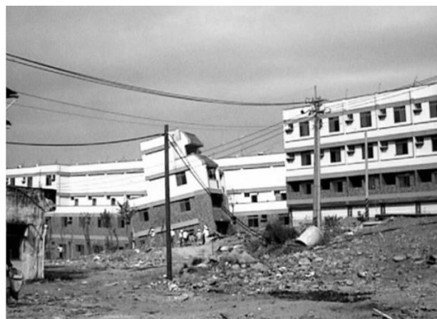
写真 1999年台湾・集集地震の断層直上における建物被害
