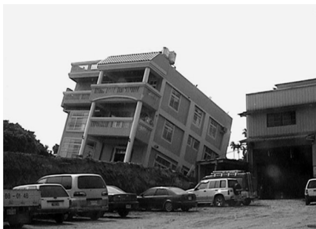
写真 1999年台湾・集集地震の断層直上における建物被害
