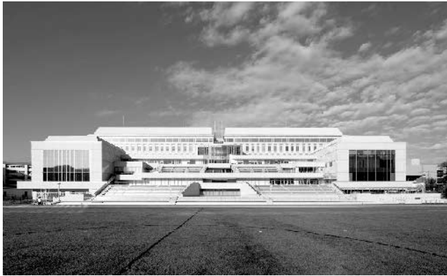
陸上競技場側外観（撮影：アド・グラフィック）
