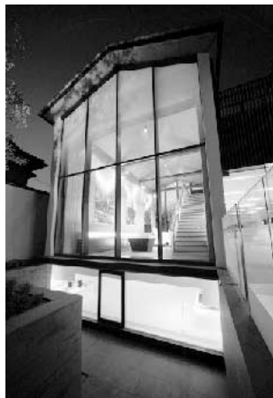
免震ピット見学スペース
