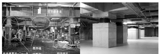
施工写真(鉄骨フレームによる建物仮受) 竣工写真(基礎免震部分LRB)
