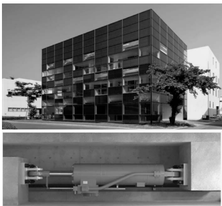
大成建設技術センター-ZEB 実証棟とパッシブ切替型オイルダンパー (撮影：大成建設株式会社)
