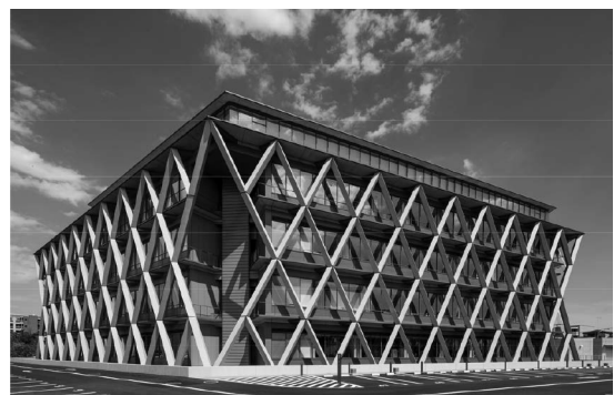
建物外観 (撮影：堀内広治)
