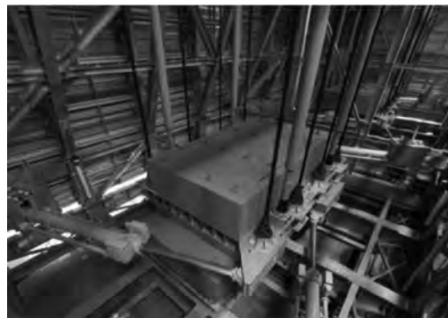
TMD 内観（撮影：鹿島建設）
