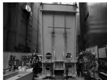
通し壁柱の建方状況 (撮影：大成建設)
