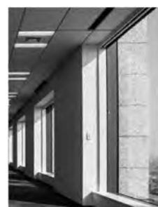
本館外壁周り内観
