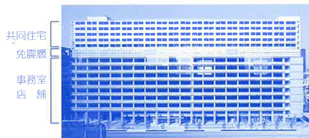
建物外観 2 (写真撮影：SS 東京)
