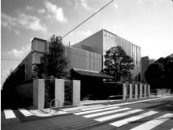
建物外観（撮影：ハットリススタジオ）
