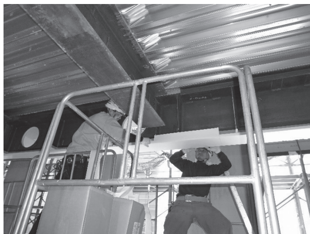
写真3 KMF梁の耐火シート施工状況
