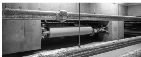
図16 オイルダンパーの再設置状況*
