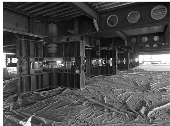
写真5 ジャッキ配置状況
