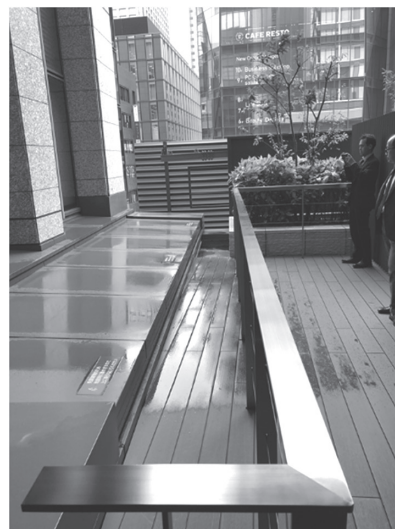
写真15 本館 (左側) と南館 (右側) をつなぐ床の免震エキスパンションジョイント
