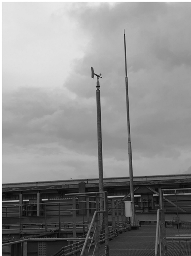
写真6 本館屋上の風向風速計（左側）
