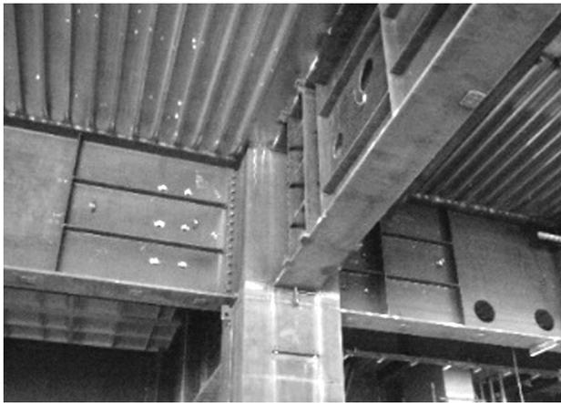
写真4 新規開発梁端部の現場外観
