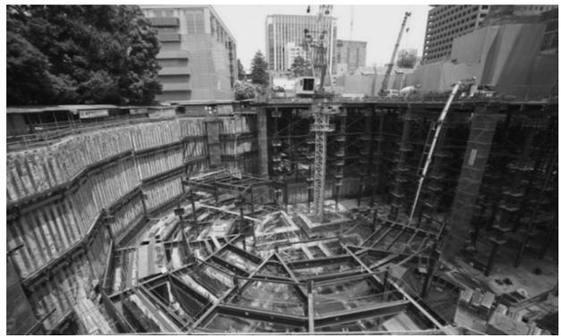
写真9 大深度アースアンカー工法
