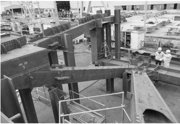
写真6 トランスファートラスの仮組状況
