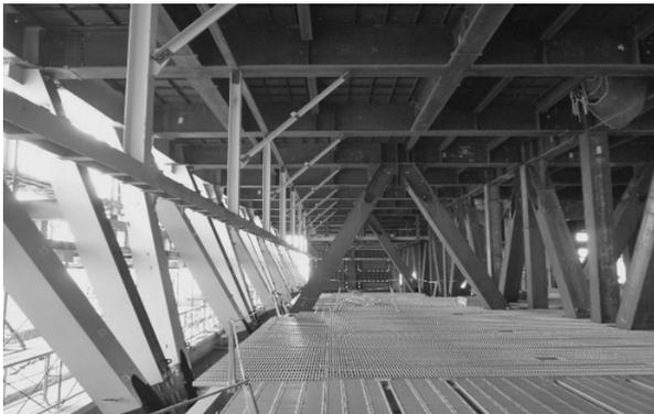
写真7 トランスファートラスの建方状況
