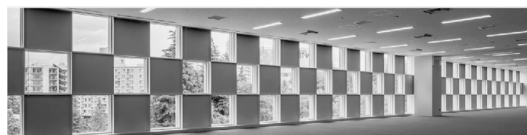
写真3 耐震格子パネル（4階の執務室）
