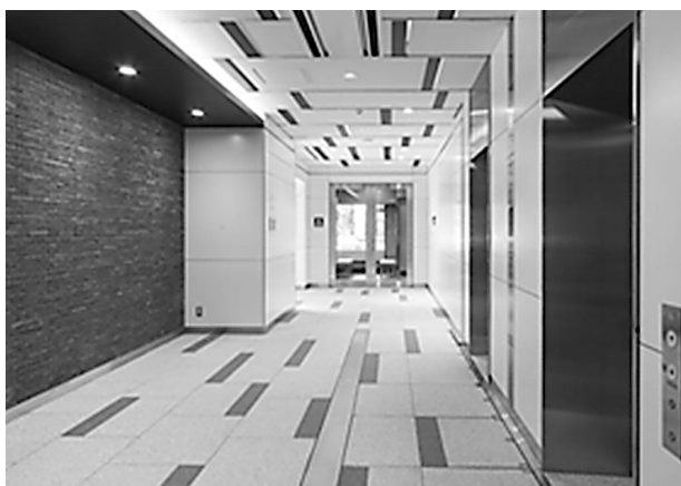
写真15 1階エレベータホール（改修後） （免震鉛直・水平スリットを設けつつ、相応しい玄関として更新）
