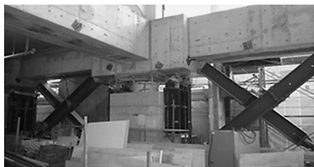
写真9 仮設ブレースにより耐震安全性を確保
