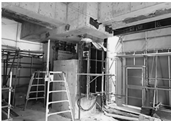
写真6 ジャッキアップ後、1階柱頭部切断撤去
