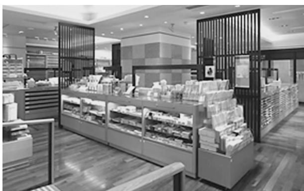
写真19 1階和紙店舗の内装（改修後） （柱が一回り大きくなり、間仕切壁に免震水平スリットを設けた以外は、オリジナルのデザインを堅持）
