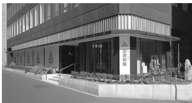
写真16 1階エントランス周りの外装（改修前）
