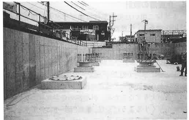
写真-2 免震部材設置状況
