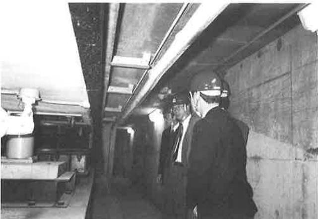
写真-3 免震層内見学
