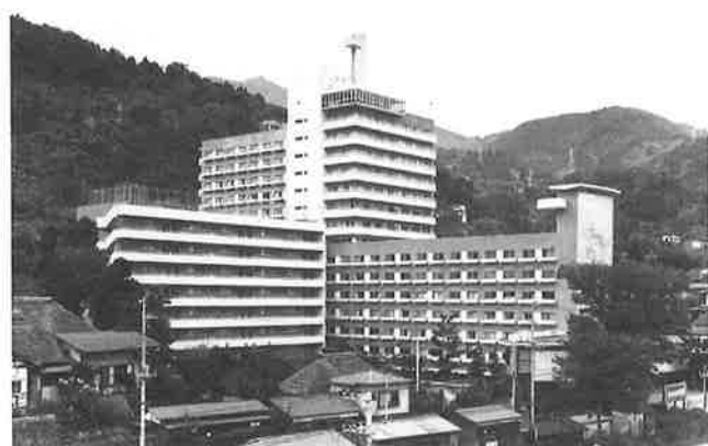
写真-1 レトロフィット免震を行う研修センター
