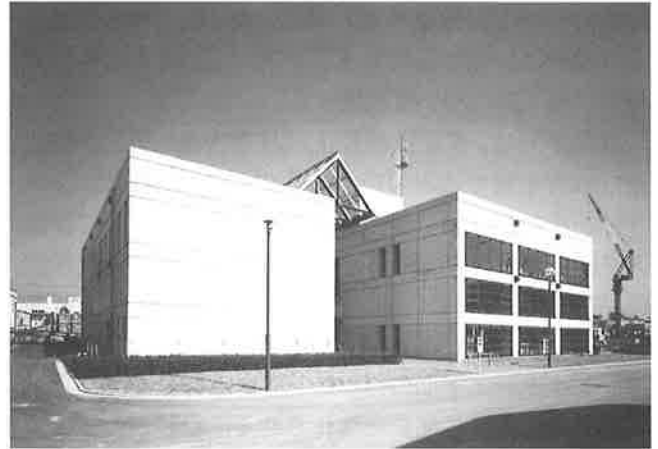
写真-1 音響実験棟の外観
