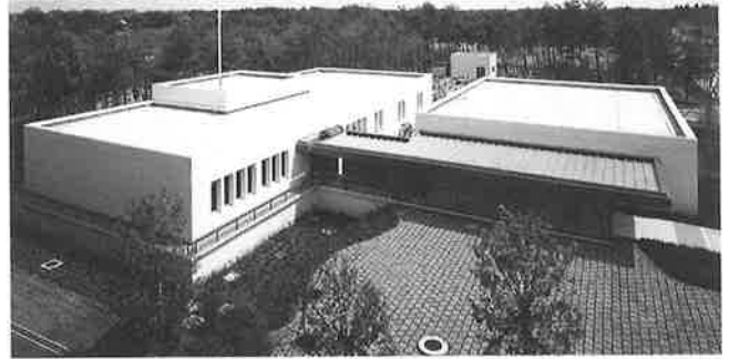
写真-1 無振動特殊実験棟の全景
