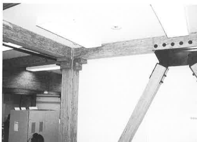
写真-2 建物内部
