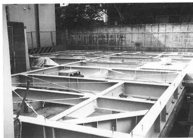
写真-7 鉄骨フレームの取付け
