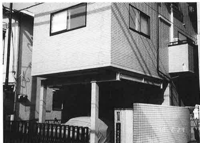
写真-1 建物全景
