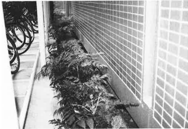
写真-3 建物外周部(植え込み)
