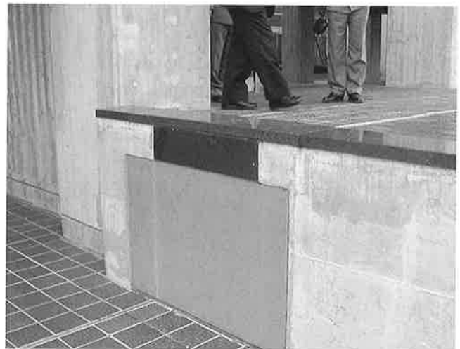
写真-5 段差のあるクリアランス処理
