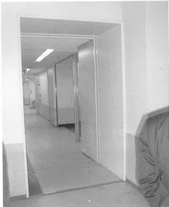
写真-8 既存建物との取合いの実際
