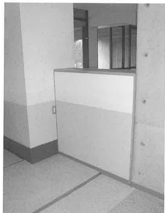
写真-6 内部のクリアランス処理
