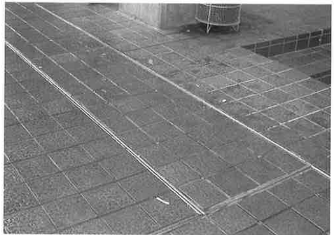
写真-4 1階のクリアランス処理
