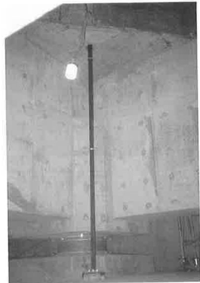
写真-2 引張抵抗用PC鋼材
