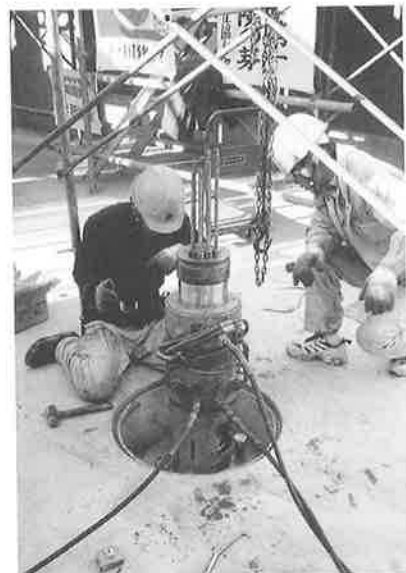
写真-3 同上張力導入時
