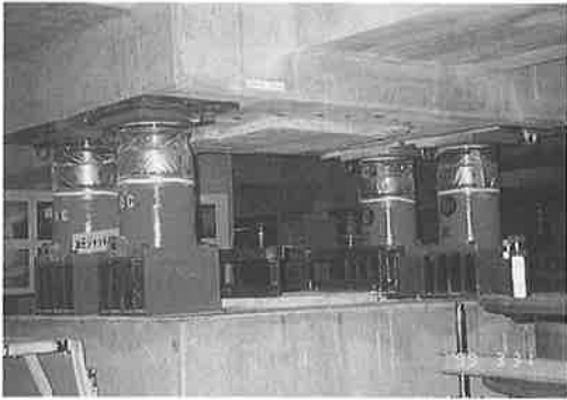
写真-2 既存躯体柱切断状況
