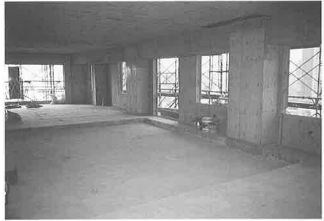
写真-2 躯体施工状況
