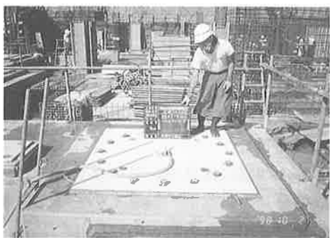
写真-2 無収縮モルタルの充填
