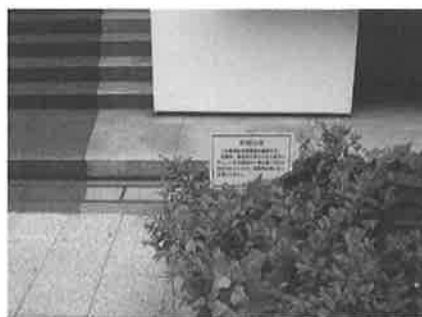
写真-3 免震構造であることを示す看板
