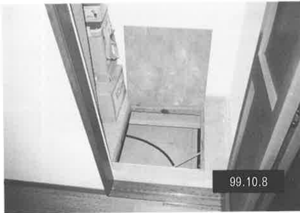
写真-4 免震層点検用ハッチ
