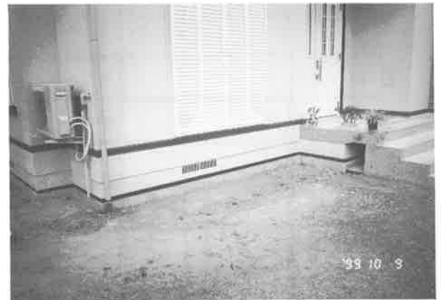
写真-8 基礎・上部構造間クリアランス処理
