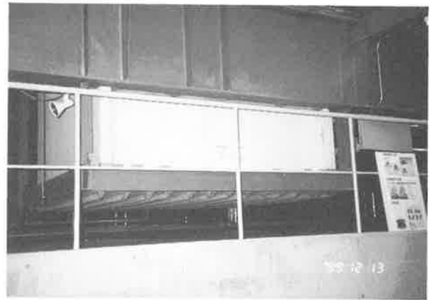
写真-9 1階床から吊り下げられたエレベータピット部
