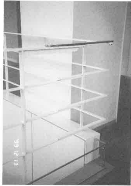
写真-8 連絡通路の免震用手摺
