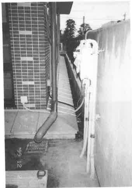
写真-4 免震可動部の取り合い
