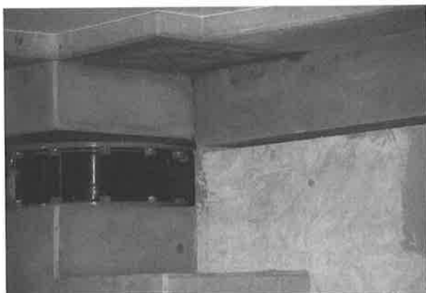
写真-4 ウォールソーで切断された壁
