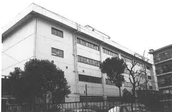
写真-1 耐震改修工事中の校舎
