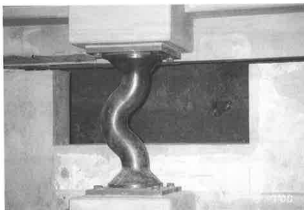
写真-5 設置された鉛ダンパー
