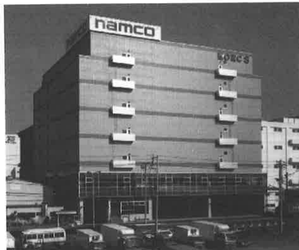
写真 建物全景
