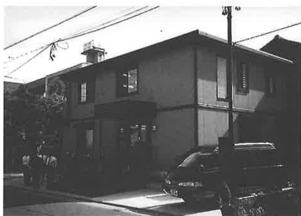
写真-1 建物外観
