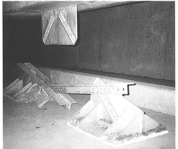
写真-2 仮設時ブレース
