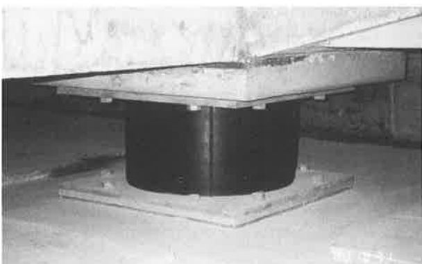
写真2 積層ゴム支承
