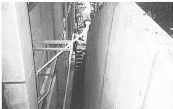
写真7 建物背面の擁壁部
