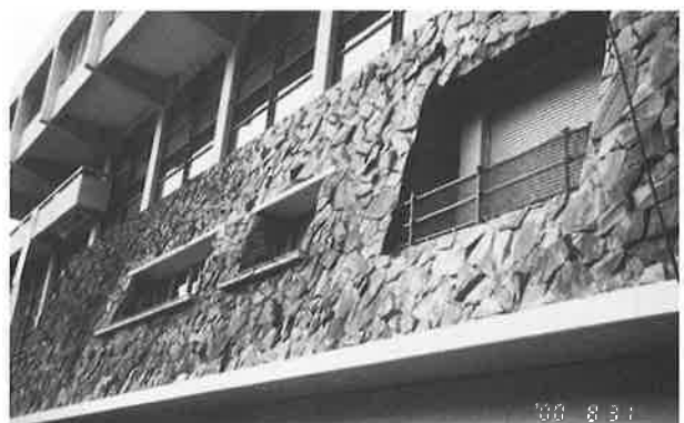
写真6 建物正面の石積み
