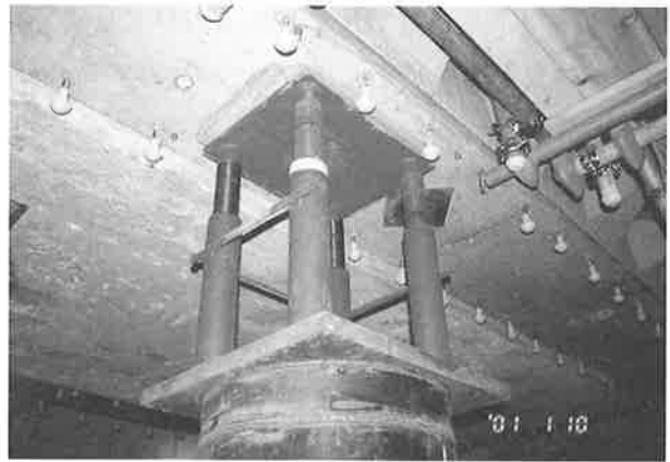
写真6 鋼管杭頭部のサポートジャッキ
