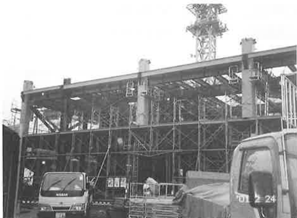
写真2 工事状況外観
