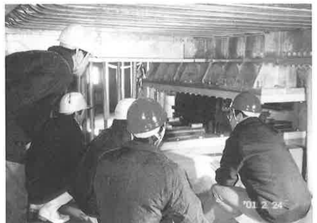
写真5 免震層で説明を聞くメンバー
