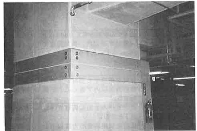
写真-2 地下1階中間層免震部
