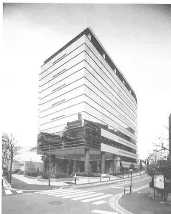
写真-1 建物外観
