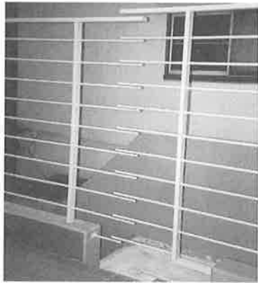
写真一7 手摺り部分
