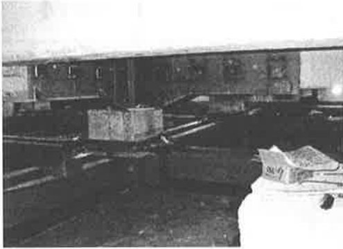
写真3 2階（免震階）床躯体新設状況
