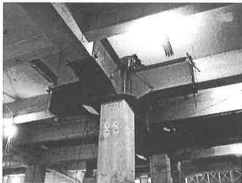
写真1 既存3階大梁補強状況
