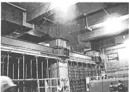
写真2 2階(免震階)大梁取り付け状況
