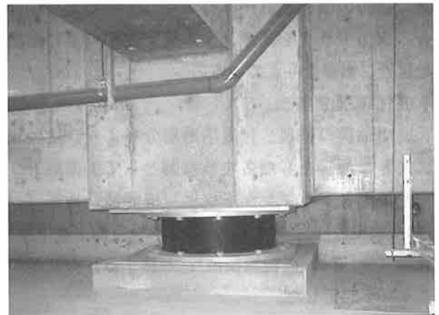
写真-2. 免震装置設置状況
