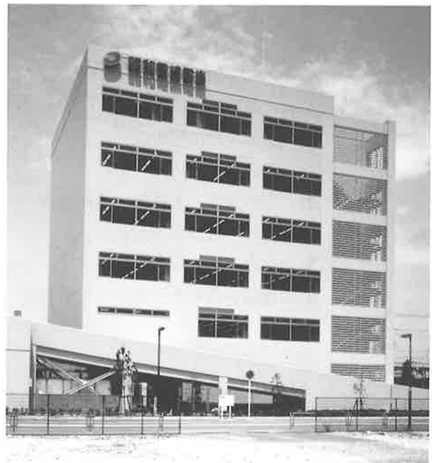
写真-1 建物外観
