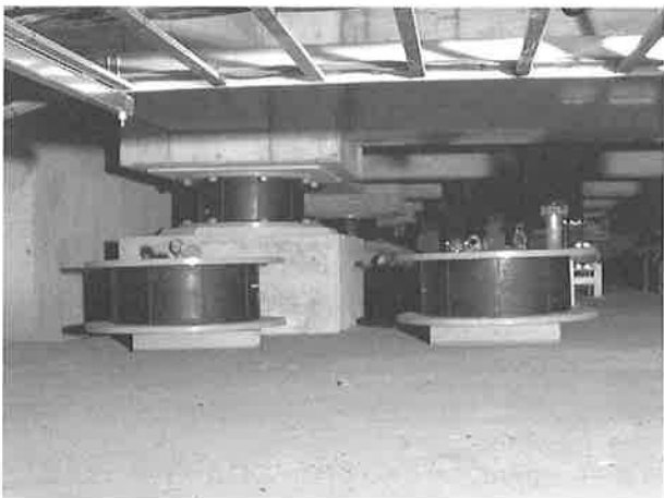
写真-4 別置き試験体
