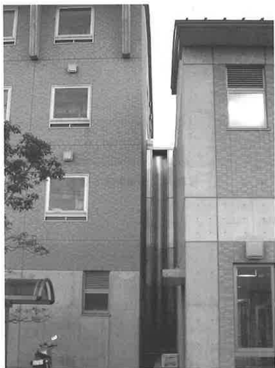
写真-8 渡り廊下 EXP.J部
