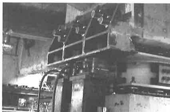
写真-8 免震部材設置状況 2
