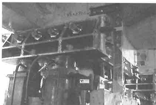
写真-7 免震部材設置状況 1
