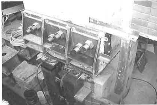
写真-10 免震部材設置状況 4
