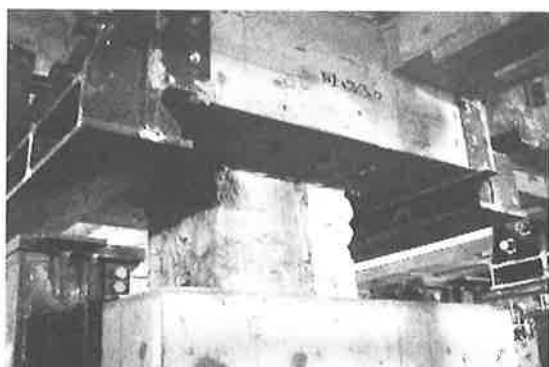
写真-4 柱・梁の補強状況 1
