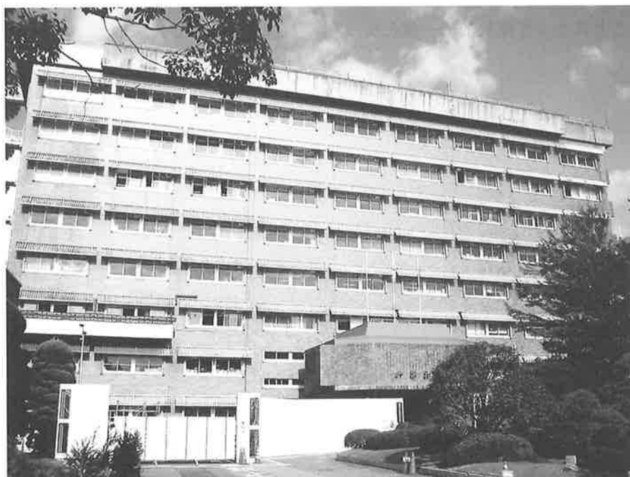
写真-1 建物外観
