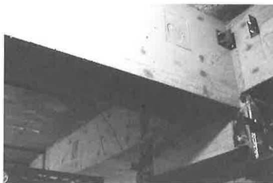
写真-6 柱・梁の補強状況 3
