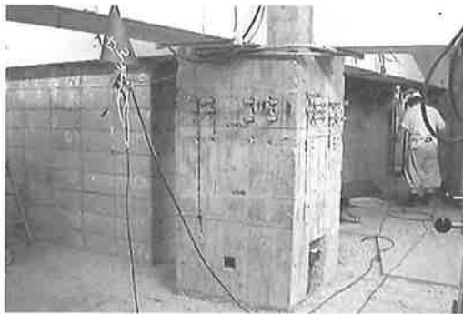
写真-4 既存躯体の表面処理及びアンカー状況
