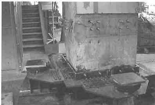
写真-5 仮受架台設置状況1
