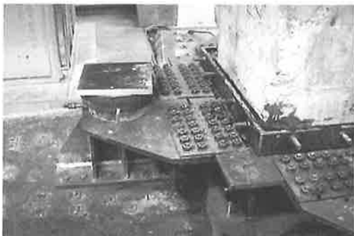
写真-6 仮受架台設置状況2
