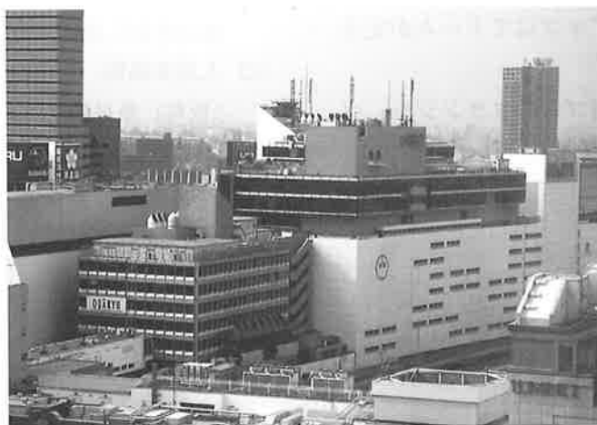
写真-1 外観写真
