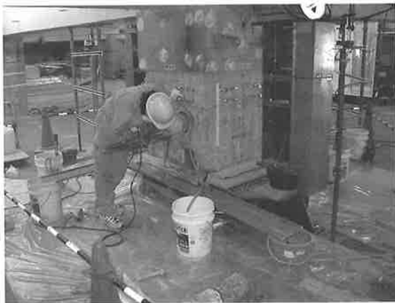
写真-2 コンクリートのコア抜き
