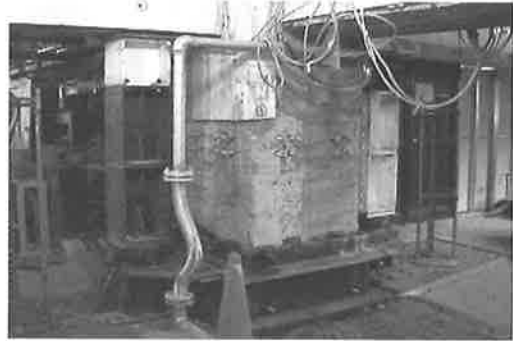
写真-7 仮受支柱設置状況
