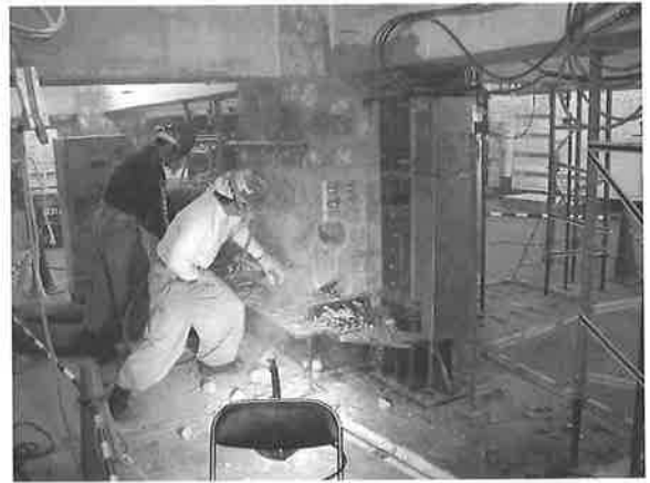
写真-3 柱の碎り工事
