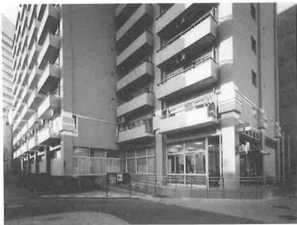
写真-1 建物外観
