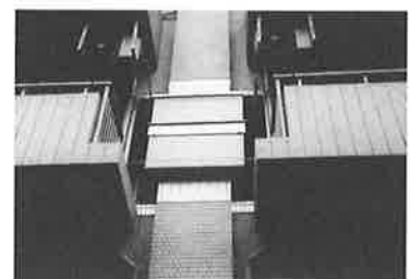
写真-7 外部のALC耐火被覆状態
