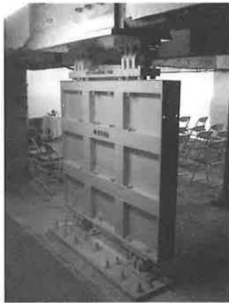
写真-3 施工時の粘性制震壁
