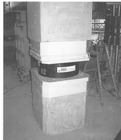
写真-2 施工時の積層ゴム支承NRI φ600
