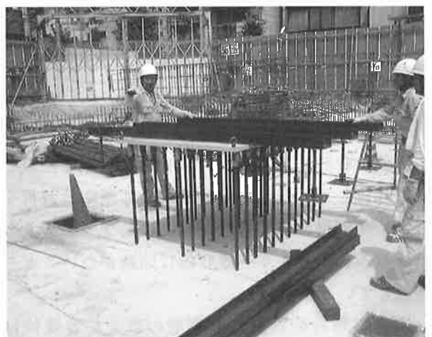
直動転がり支承の下部定着鉄筋
