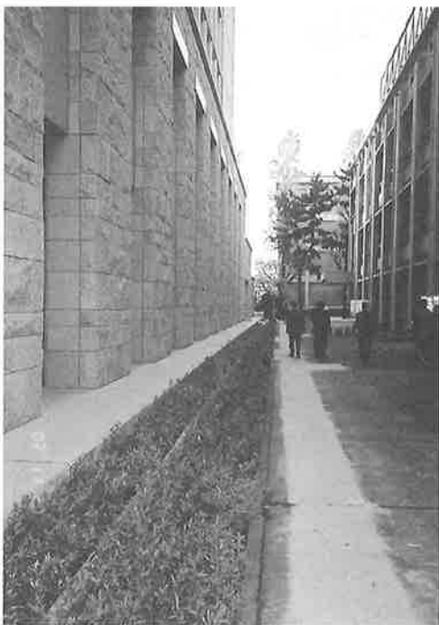
写真-6 建物北側の植込み部
