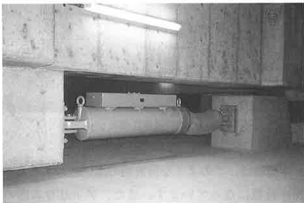
写真-10 オイルダンパー設置状況
