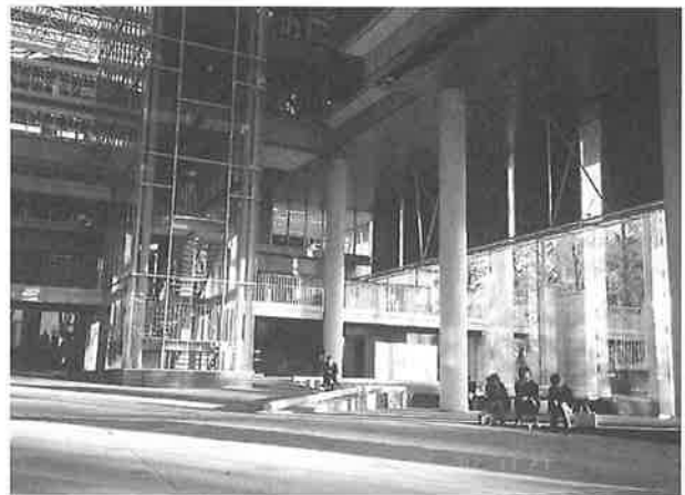
写真-8 7層吹き抜けのアトリウム空間
