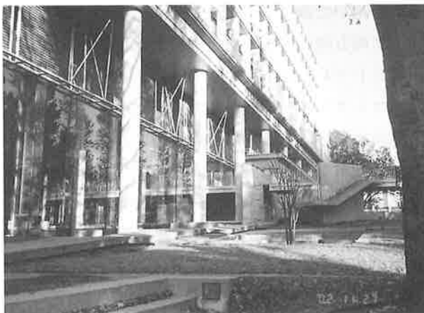
写真一 2 建物南側の外観
