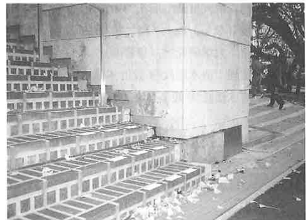
写真一 4 建物西側の可動部と階段の納まり
