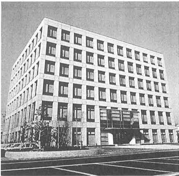
写真-1 建物外観
