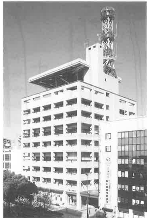
写真-1 建物外観
